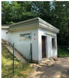
Ein undichtes Dach beim Hochbehälter Peuerbach, Kastlingeredt, machte eine Teildachsanierung (Zimmereiarbeiten und neues Blechdach mit Hinterlüftung) erforderlich. Die Arbeiten wurden im Sommer in Angriff genommen. Die Firma Eizenberger, Holzbau aus Peuerbach führte in Zusammenarbeit mit unserem Bauhof die Sanierungsarbeiten durch. Nun wird noch der Putz ausgebessert und die Außenfassade neu gemalt. Die Dachsanierungskosten betragen ca. € 10.000,--.
